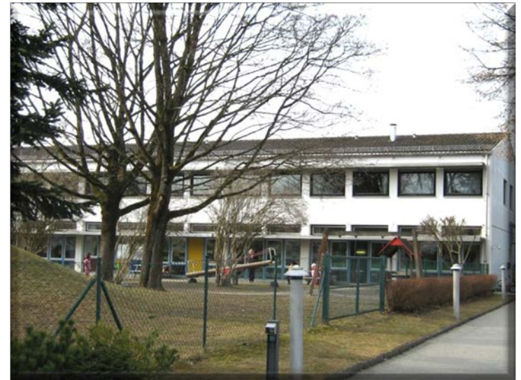
Altbestand vor Abriss
